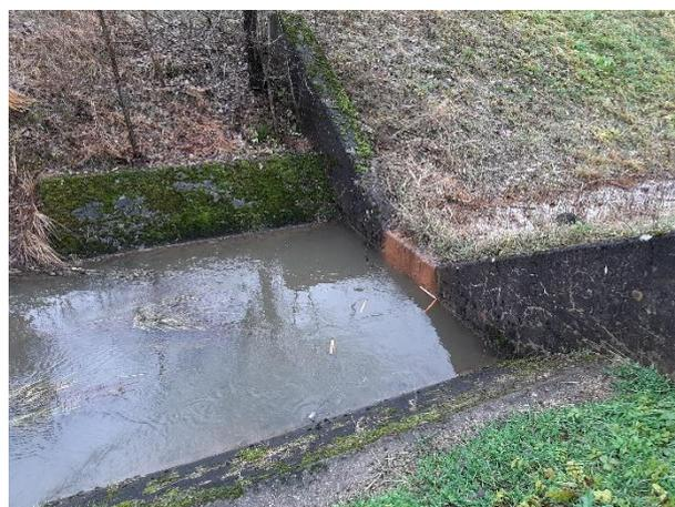
Foto 2: Höhenversatz im «Linth Nebenkanal» → Weiterleitung Bachwasser in Steinerrietkanal (in Durchlass)
