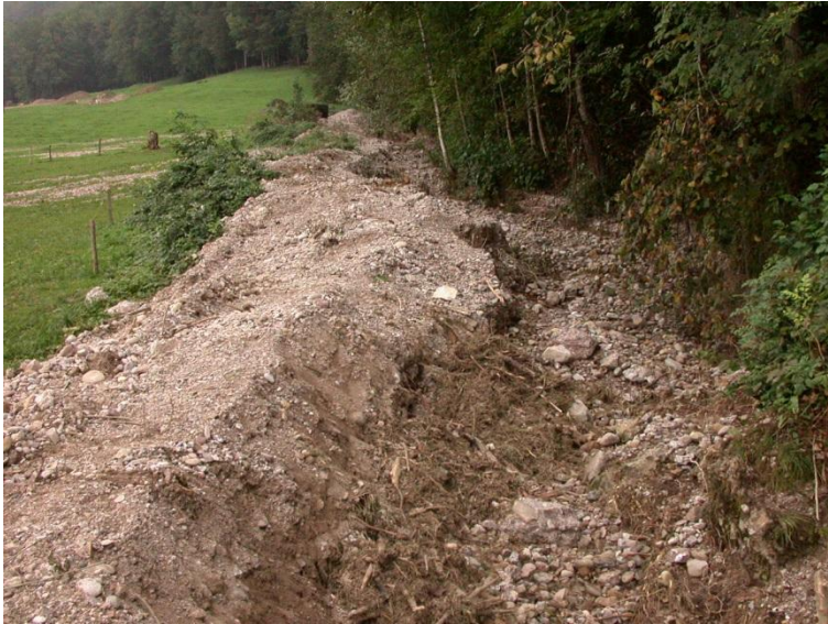
Abbildung 5: Ausgebaggertes Gerinne nach dem Hochwasserereignis 2006 (vgl. Abbildung 8, oranger Abschnitt)
