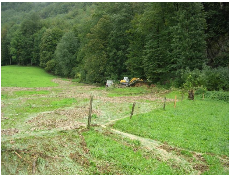
Abbildung 6: Ausbruch infolge Gerinneauflandung, Hochwasserereignis 2006 (vgl. Abbildung 8, roter Abschnitt).
