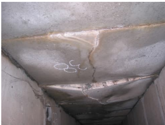
Abbildung 8: Kanaldecke entlang der Rietstrasse an verschiedenen Stellen eingebrochen.
