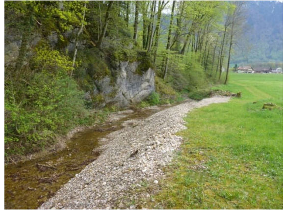
Abschnitt 0: Einlaufbereich in den Feststoffrückhalt.
