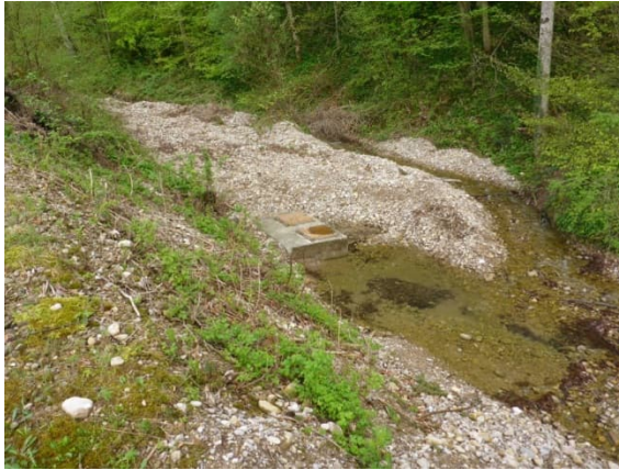
Abschnitt 0: bergseitig des Feststoffrückhalts.
