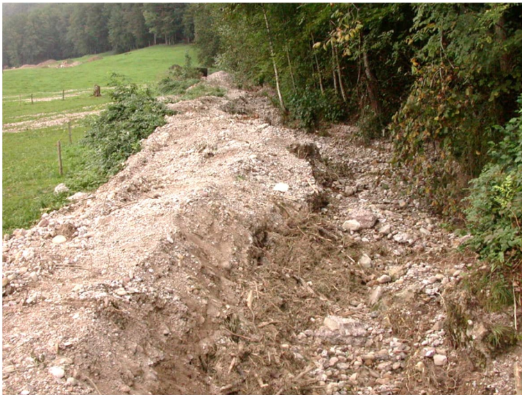
Abbildung 3: Ausgebaggertes Gerinne nach dem Hochwasserereignis 2006 (vgl. Abbildung 6, oranger Abschnitt)
