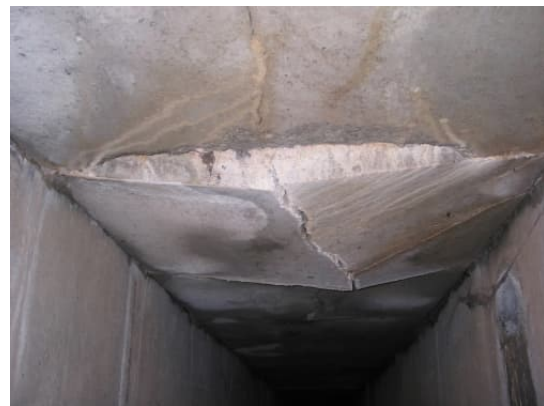
Abbildung 8: Kanaldecke entlang der Rietstrasse an verschiedenen Stellen eingebrochen.
