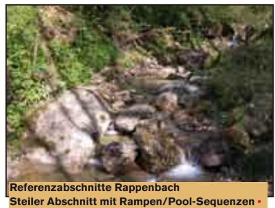
Durch die Geschiebeentnahme entsteht jedoch ein Geschiebedefizit im Unterwasser, welches die Ufer- und Sohlenerosion begünstigt. Das Gerinne muss entsprechend stabilisiert werden. In steileren Abschnitten mit 2 - 5% Gefälle erfolgt dies mit einer Abfolge von Rampen und in flacheren Abschnitten (1 bis 2% Gefälle) mit einem Deckwerk von regelmässig verlegten Einzelblöcken. Die Ufersicherung erfolgt mit Blocksteinen und einer standortgerechten Ufervegetation.
